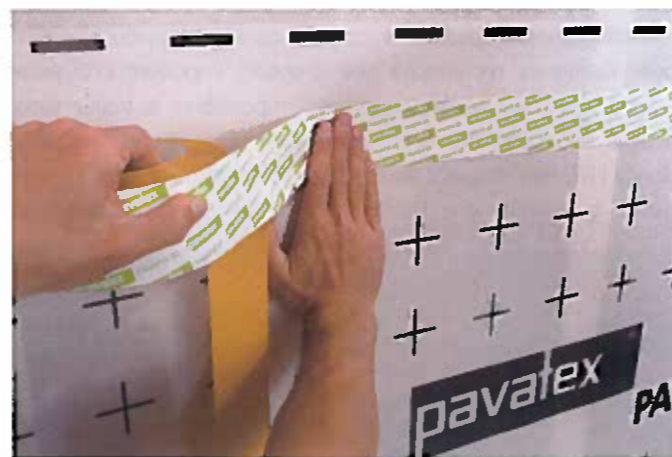
Scotch Pavatex pour étancher deux lés de membrane.
