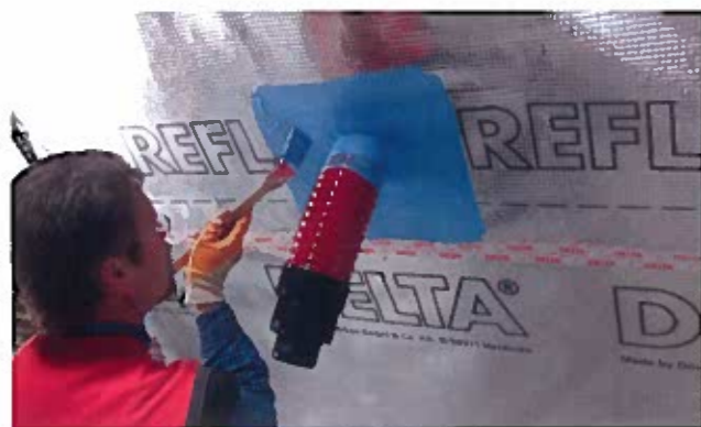
Delta® Liquix FX de Doerken assure l'étanchéité à l'air au pinceau.
