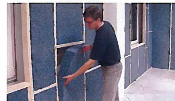
Pose de panneaux d'isolant Metisse en coton recyclé.
