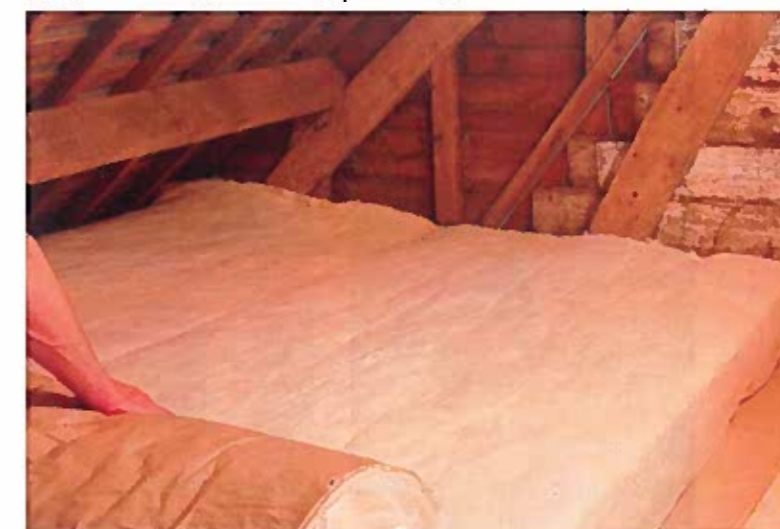
Pose de panneaux d'isolant Metisse en coton recyclé.
